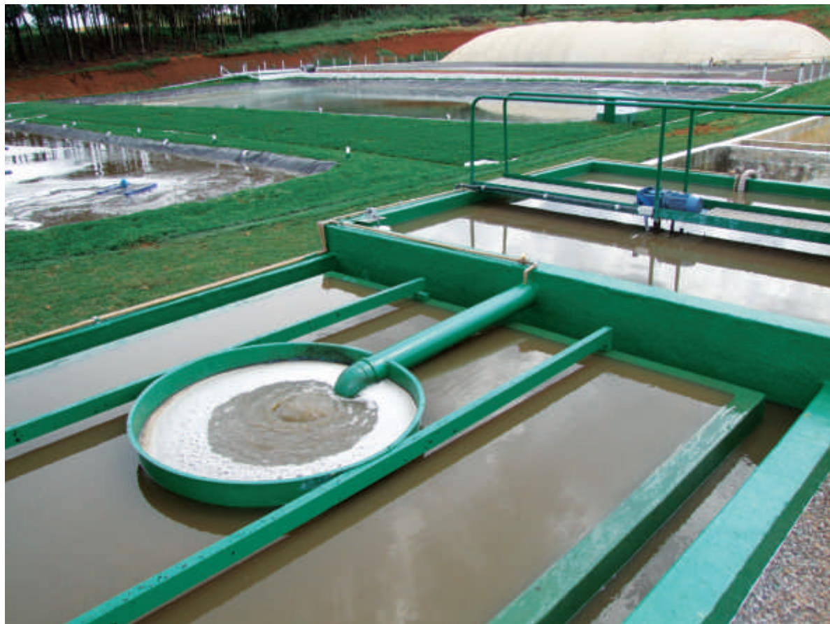
Complexo onde está instalada a ETE - Estação de Tratamento de Efluentes – Granja Ibicuí
