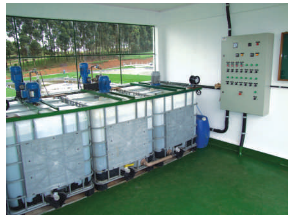
Equipamentos que contribuem para o tratamento dos dejetos
