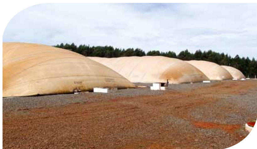
Quatro Biodigestores produzem gás para alimentar creches de suínos
