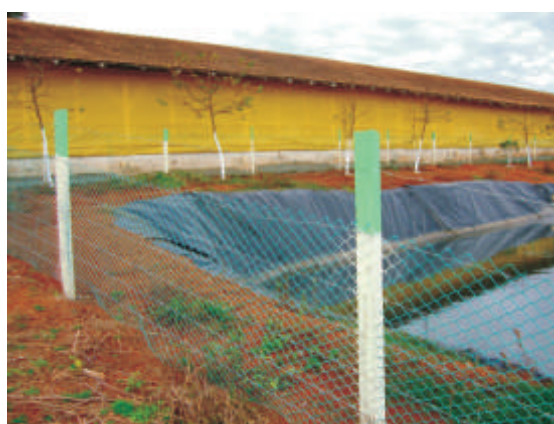
Pocilga e esterqueira cercadas
