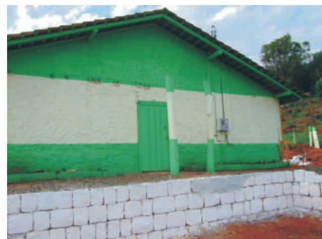
Área externa - pintura e melhorias
