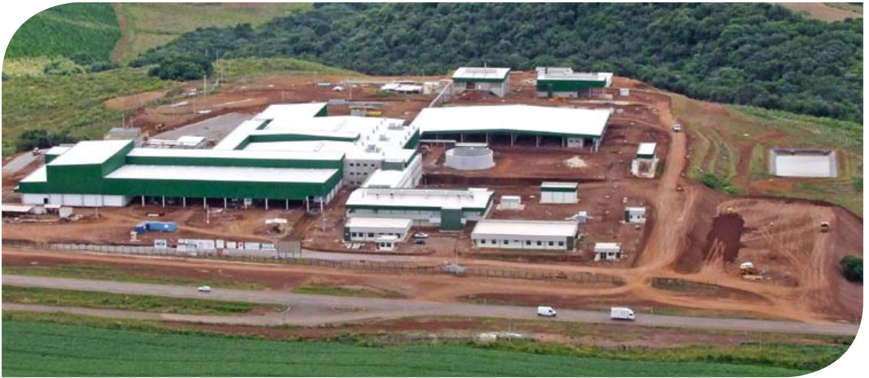
Imagem aérea da Unidade Industrial de Abate de Suínos
