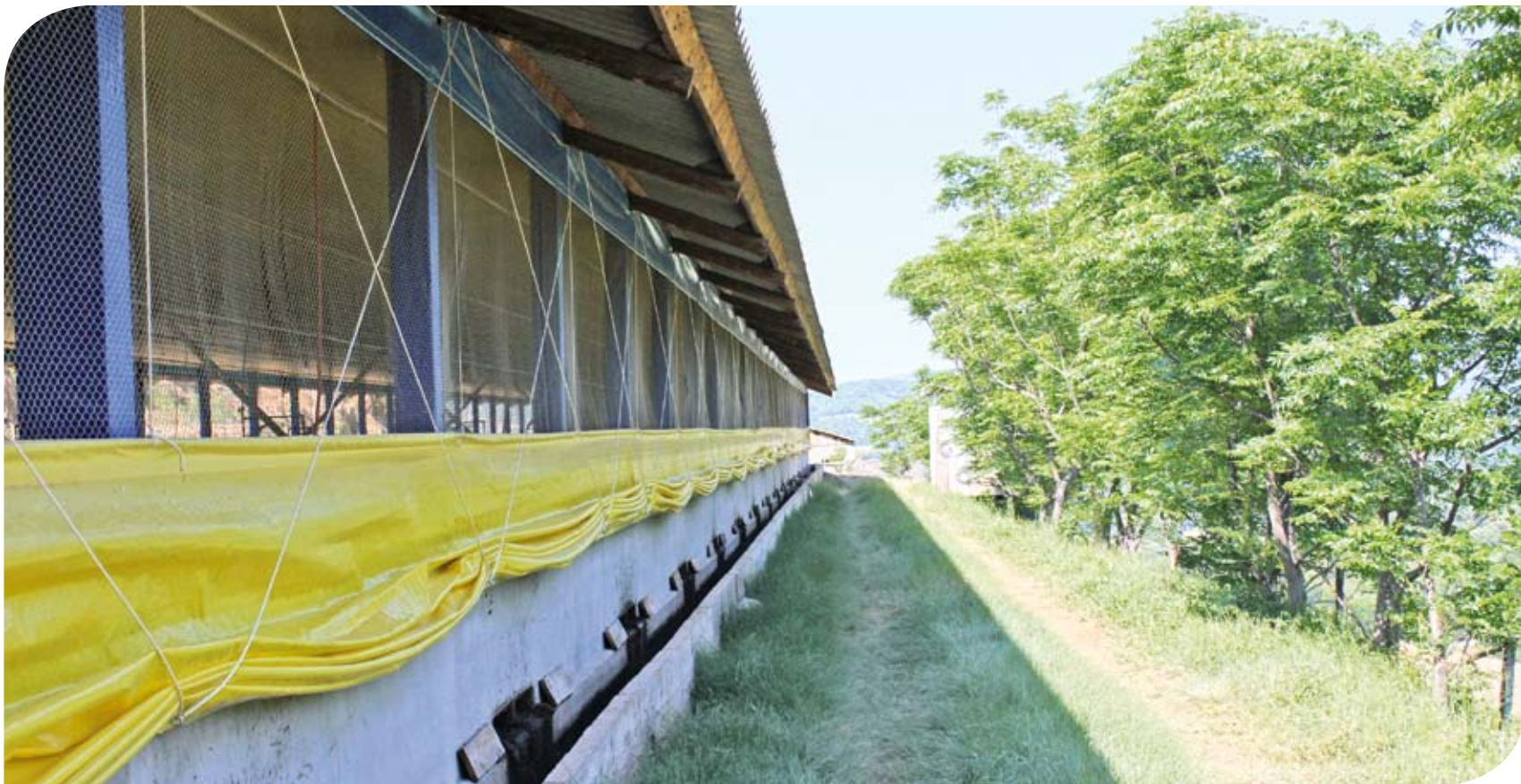
Cortinas elétricas e árvores ao lado das pocilgas são alternativas para minimizar as altas temperaturas dos locais no verão
