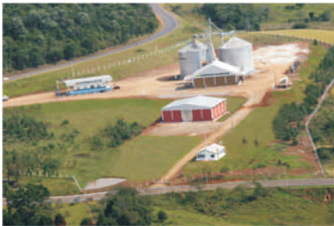
Vista área da unidade
