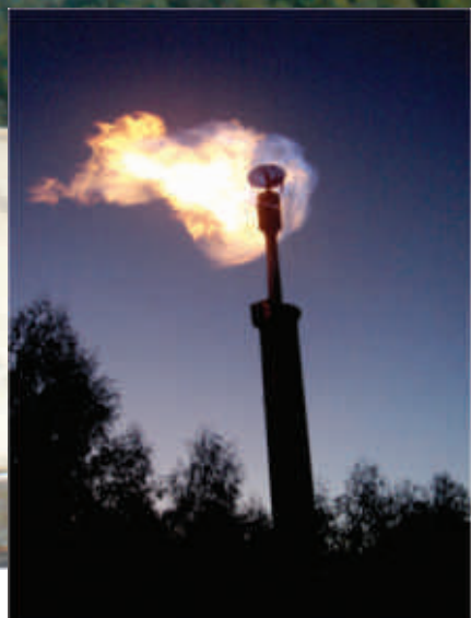
Queimador do gás produzido no biodigestor
