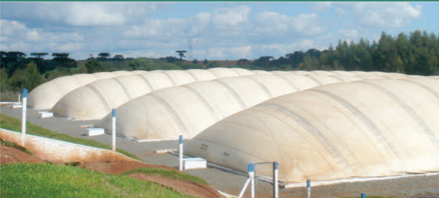
Biodigestores instalados nas granjas reprodutoras de suínos
