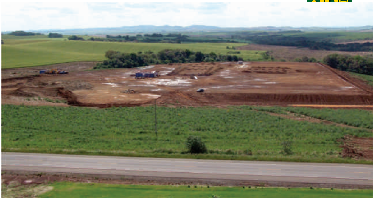
Obras serão concluídas no início de 2009
