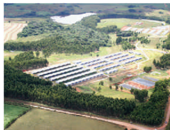
Vista área da estrutura – 3120 matrizes
