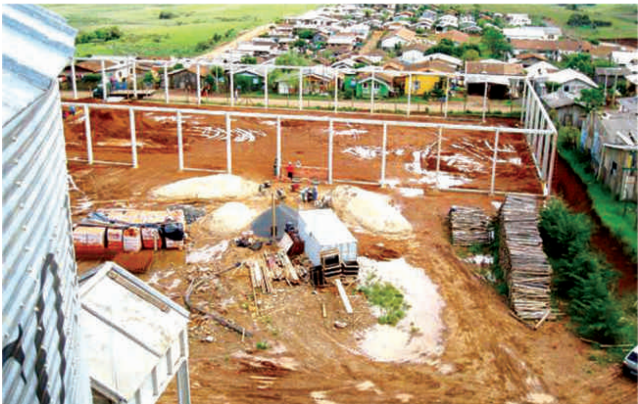
Obras na unidade de Campo Belo do Sul
