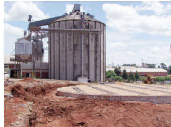
Silos armazenagem da matriz Copercampos
