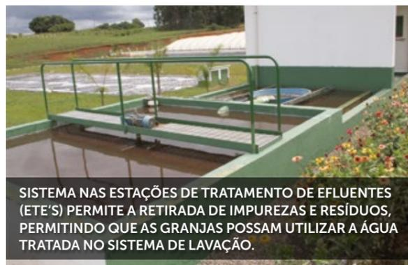
**SISTEMA NAS ESTAÇÕES DE TRATAMENTO DE EFLUENTES (ETE'S) PERMITE A RETIRADA DE IMPUREZAS E RESÍDUOS, PERMITINDO QUE AS GRANJAS POSSAM UTILIZAR A ÁGUA TRATADA NO SISTEMA DE LAVAÇÃO.**
