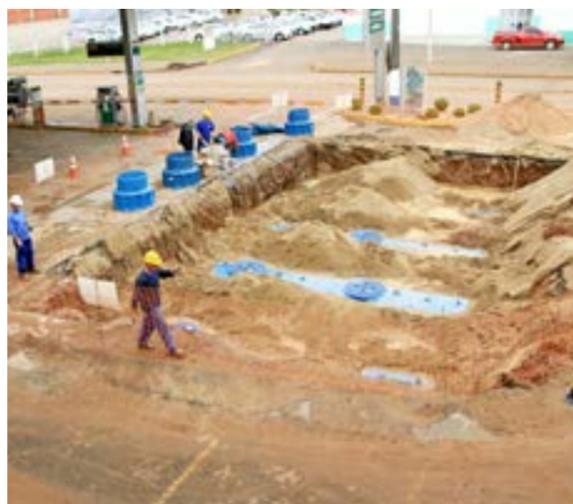
Reforma ampliou capacidade de armazenagem para 180mil litros de combustíveis
