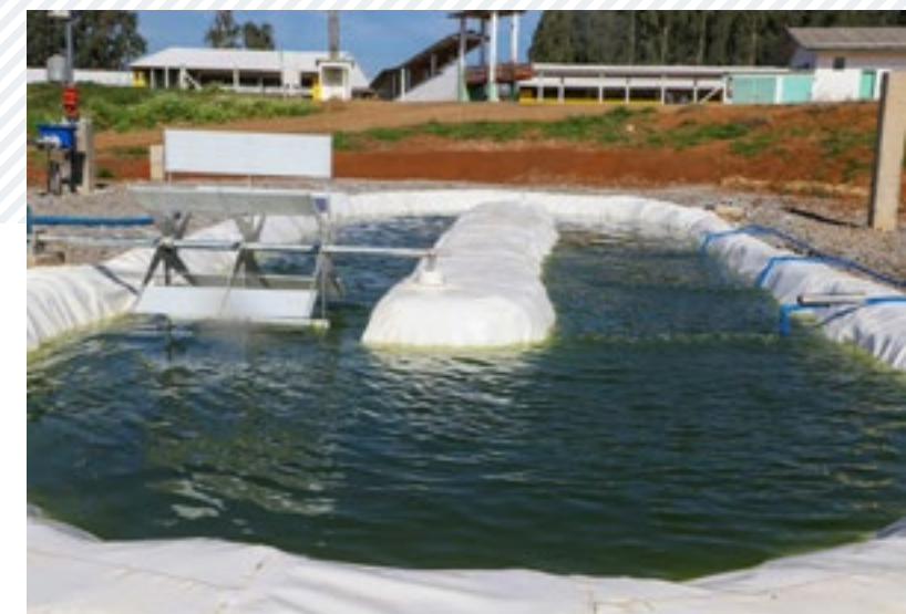
Projeto com Laboratório Lactec, prevê a geração de biometano a partir do gás gerado pela decomposição dos dejetos suínos e a sua utilização para gerar energia.
