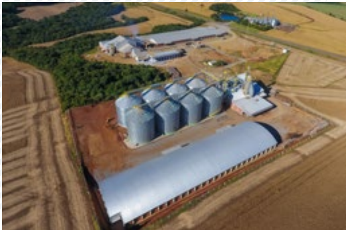
Finalização das obras na unidade 71 na área de cereais.
